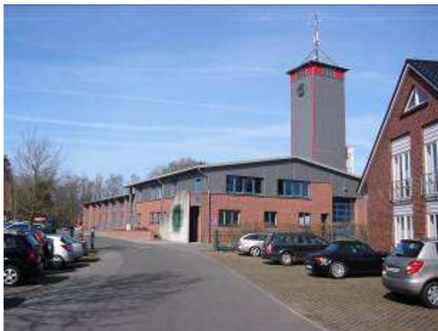
Abb. Blick von Süden auf das Hauptgebäude der Technischen Kreisfeuerwehrzentrale (R. Pollok 23.4.2011)
