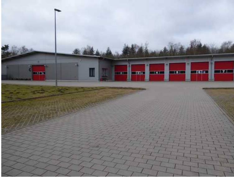
Abb.: Katastrophenschutzzentrum mit „Halle C“ am südlichen Ende
